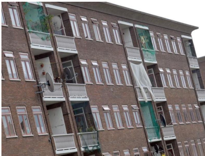
Op verzoek van bewoners plaatst Staedion soms netten vanwege duivenoverlast op balkons
